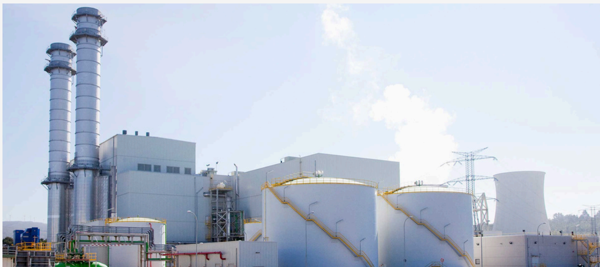
Central eléctrica de ciclo combinado das Pontes. Foto: Endesa.
